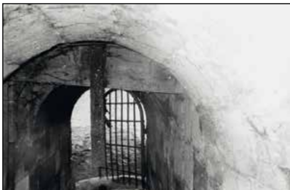
Pohled z vnitřní části kanalizace do pevnostního příkopu. Na snímku zbytek dřevěných stavidel upevněných na ocelovém táhlu (1992). Zdroj Památník Terezín
