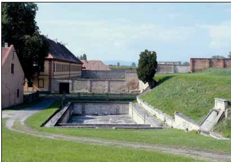
Vstup do automatické čerpací stanice ve svahu. Zdroj Památník Terezín
